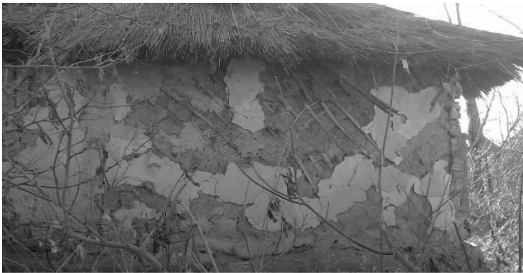
Рис. Б.1. Уліплена стіна хати глиною з соломою; дах, покритий соломою (с. Скрипаї, Зміївський район, Харківська обл., будівля початку XIX ст.)
